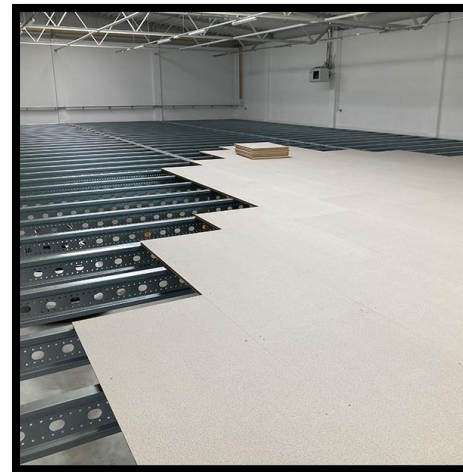
38 mm P6 sous-face blanc, surface C-dur de lux : antidérapant moyen, surface aspect ciment
